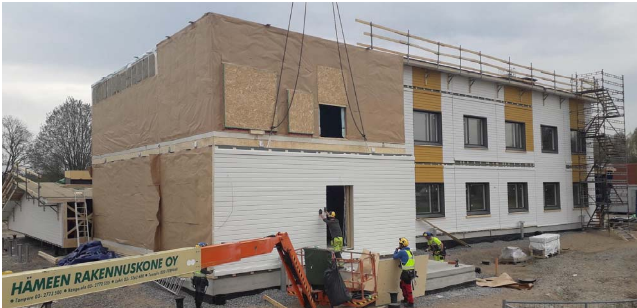
Kuva: TATE-konttien US-elementti asennusta
