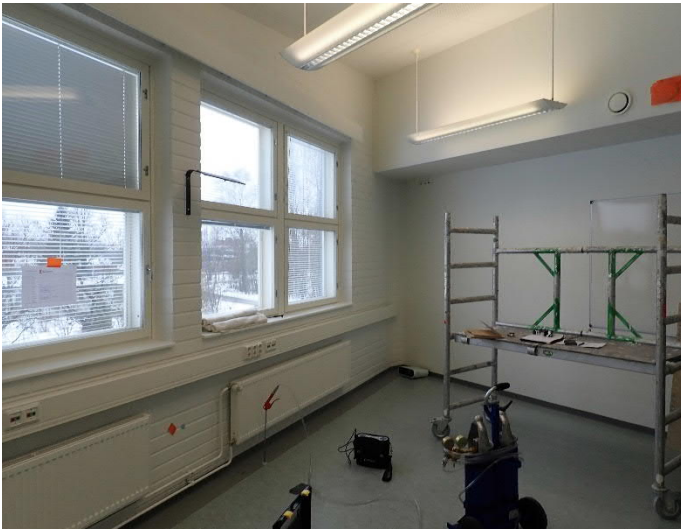
Kuva 1: Merkkiaineikaasun syöttö tilan 201 lattiarakenteeseen ulkoseinän lähelle.
