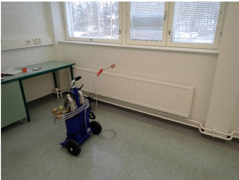
Kuva 6: Tilassa 204 merkkiainetta syötettiin ikkunoiden alapuolelle ulkoseinärakenteeseen.
