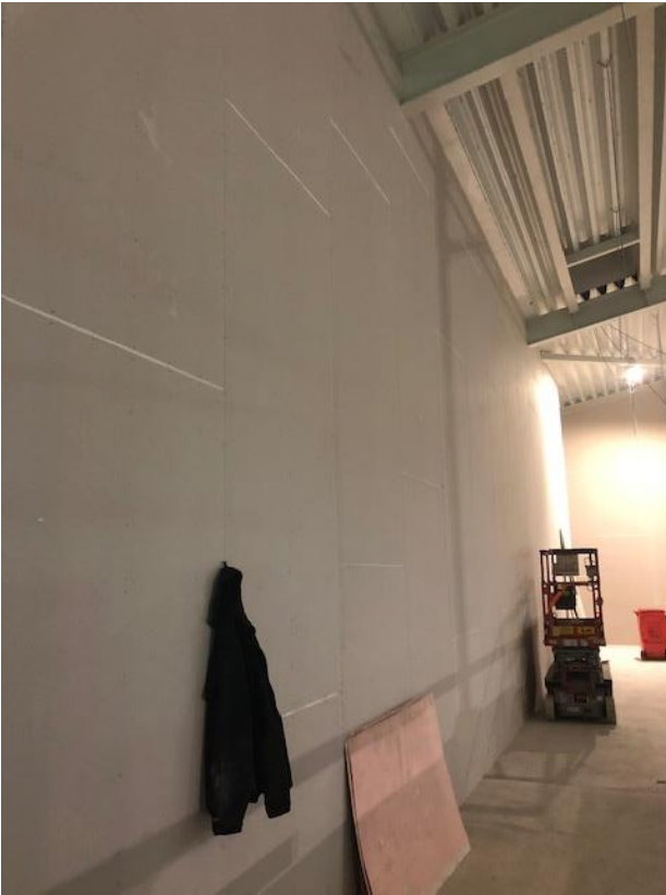
Iv-konehuoneen seinä salin puolella. Seuraavaksi tasoite- ja maalaustyöt käyntiin.
