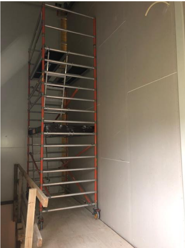
2. krs väliseinätyöt käynnissä teknisten tilojen seinien kohdalla.
