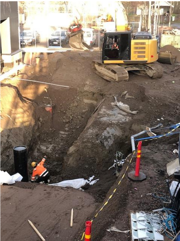
Ulkoalueilla tehdään vesijohtojen ja viemäreiden asennuksia.
