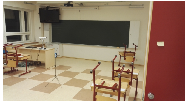
Kuva 2. Luokkatilojen pääasiällisena lattiamateriaalina on vinyylilaatta.
